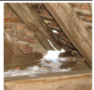
Verrottete Holzenteile
