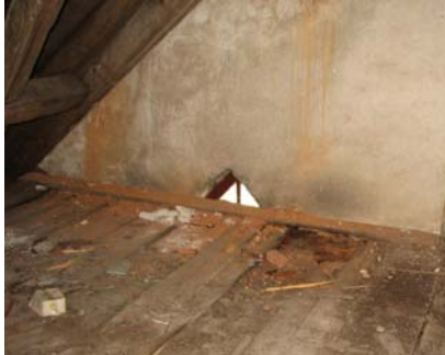
Elemente putrezite pe partea de vest a navei
