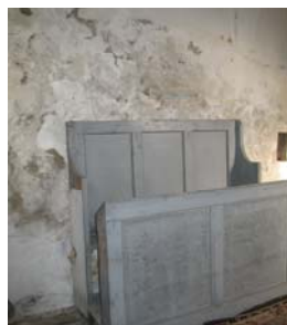
Tencuieli afectate de umiditate la interior și exterior
