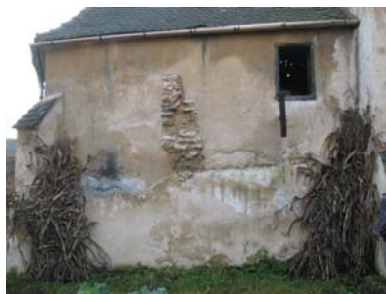
Tencuieli afectate de umiditate la interior și exterior
