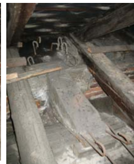
Intervenții cu beton armat
