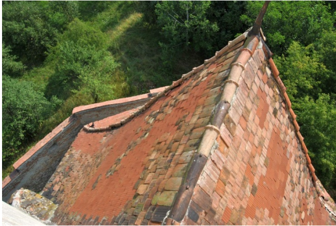
Abb. 34 – Dach, Chor, Nordost
