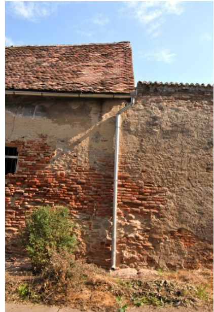
Abb. 45 – Kampfhaus, Mauerwerksschäden
