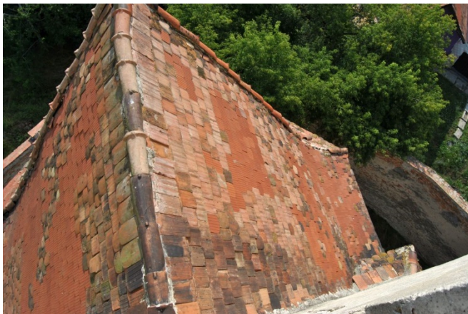
Abb. 35 – Dach, Chor Südost
