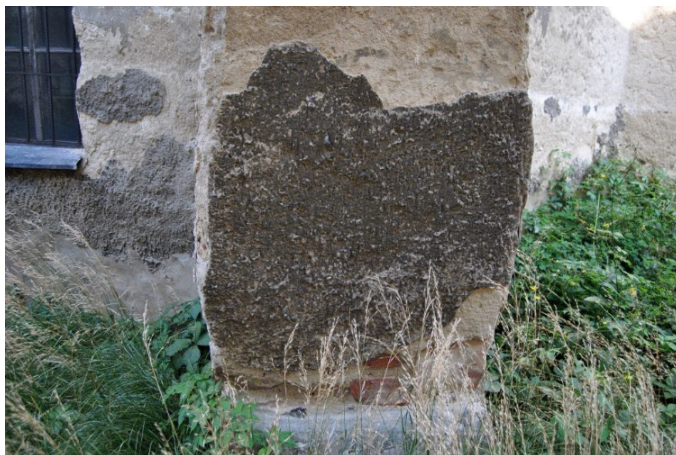
Abb. 22 – Stützpfeiler, Zementputz
