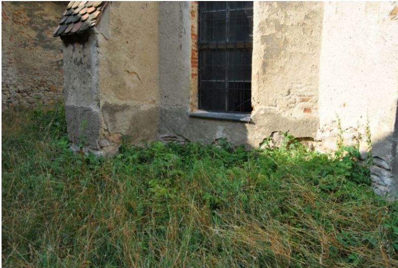
Abb. 27 – Chor, Nord, angehäuften Erde außen
