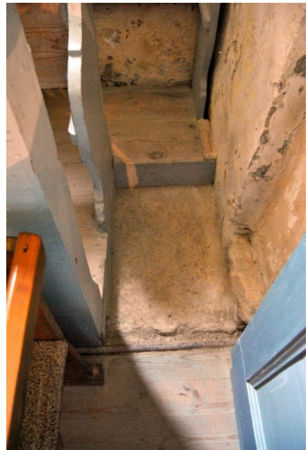
Abb. 09 – Langhaus, unter Westempore, Feuchtigkeitsschäden
