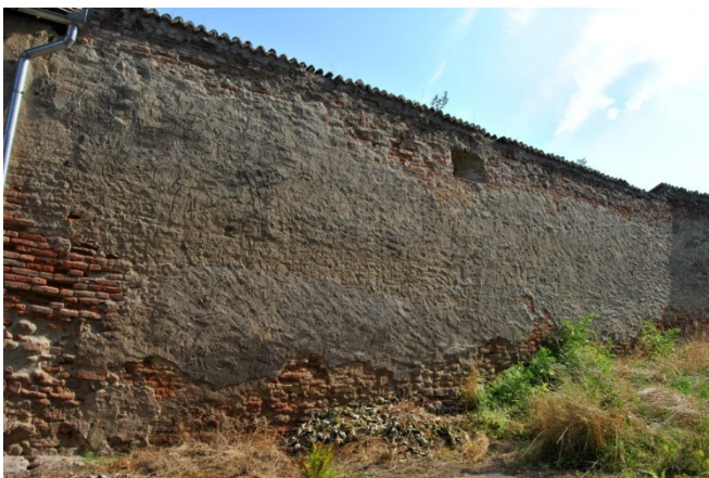
Abb. 50 – Ringmauer, Nord, Zementschlämme
