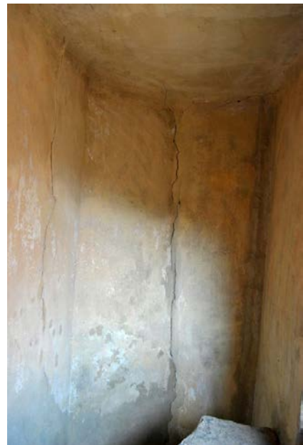
Abb. 26 – Nordempore, Fugenriss
