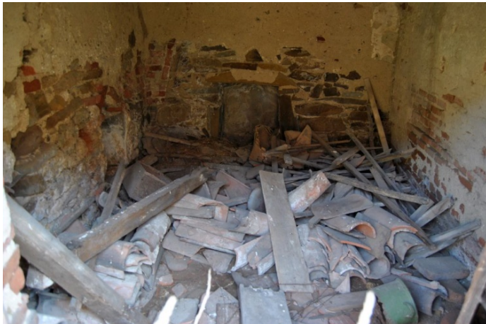
Abb. 18 – Sakristei, Raum von außen zugänglich
