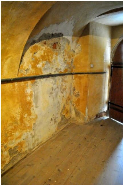
Abb. 09 – Langhaus, unter Westempore, Feuchtigkeitsschäden
